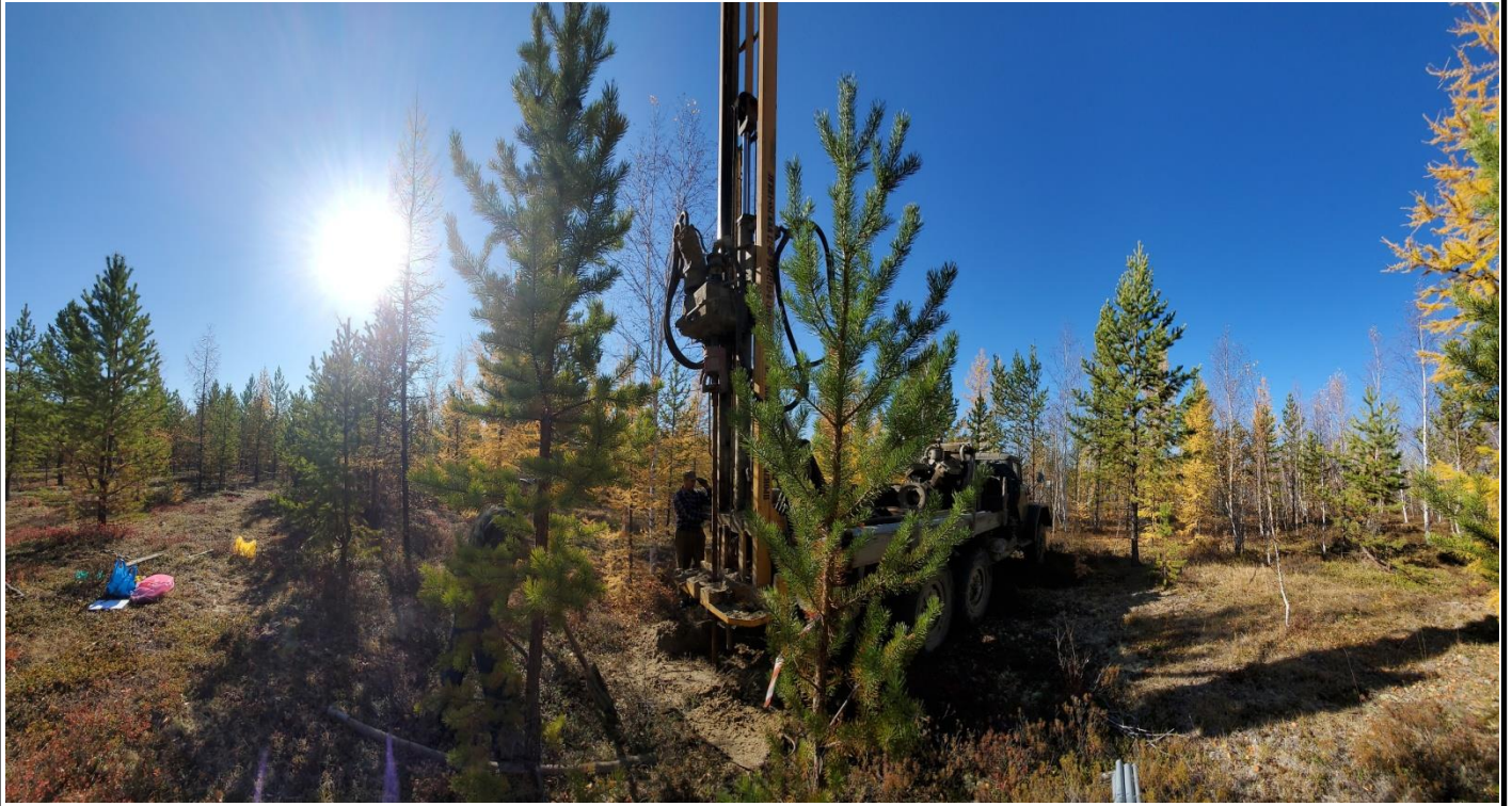
Фото 3. Процесс бурения скважины №6
