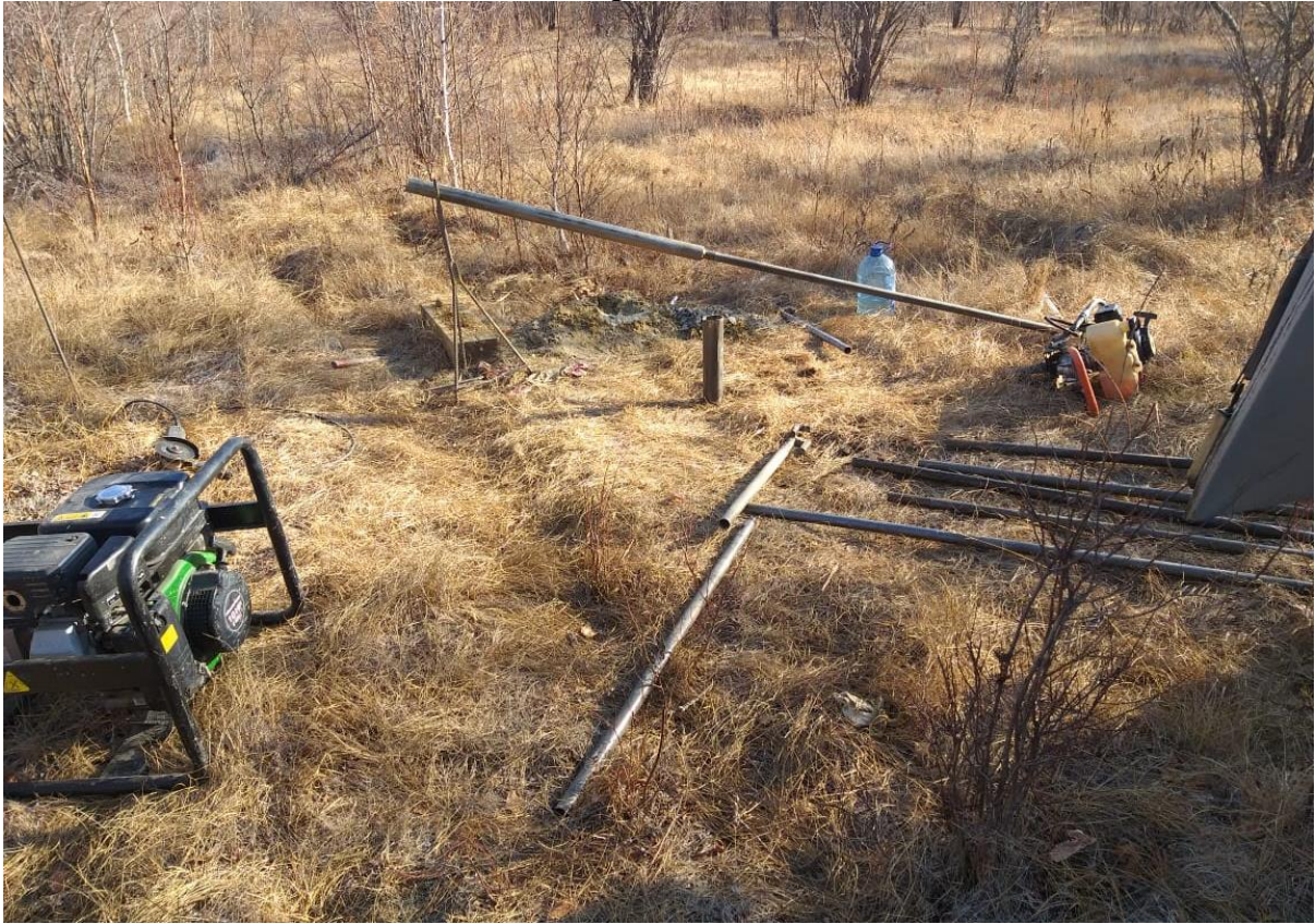
Фото 7. Процесс бурения скважины №12
