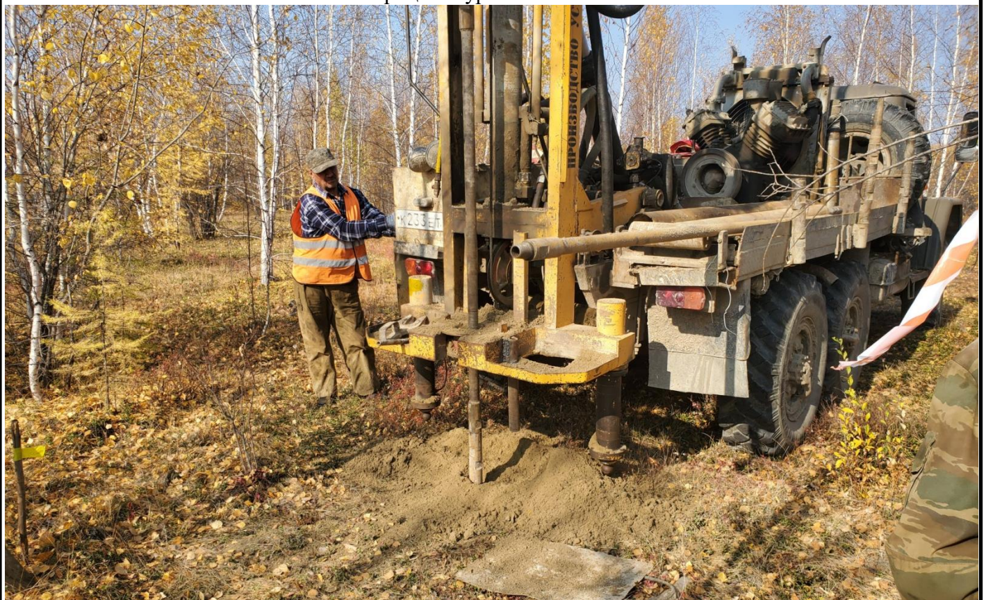
Фото 6. Процесс бурения скважины №10
