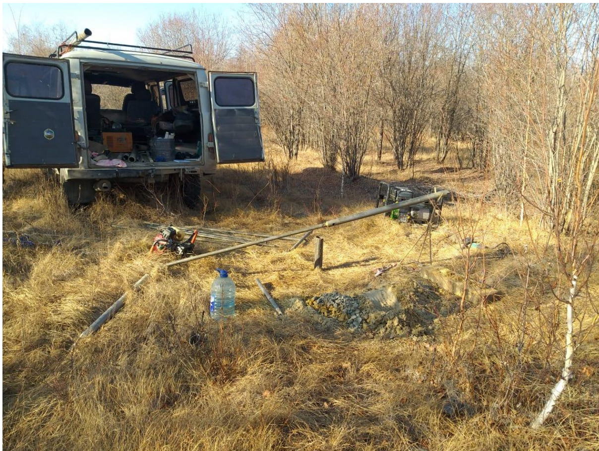
Фото 11. Процесс бурения скважины №30
