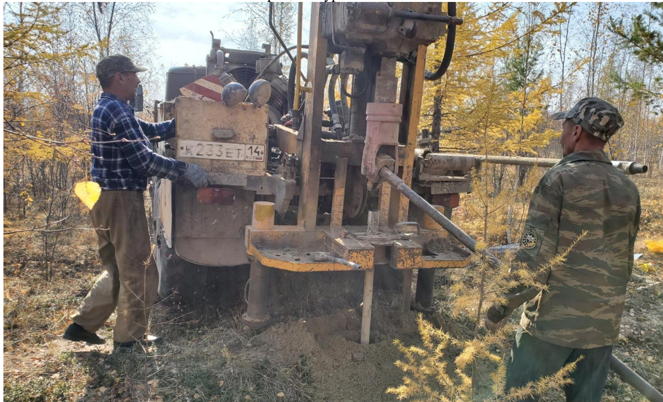
Фото 2. Процесс бурения скважины №5
