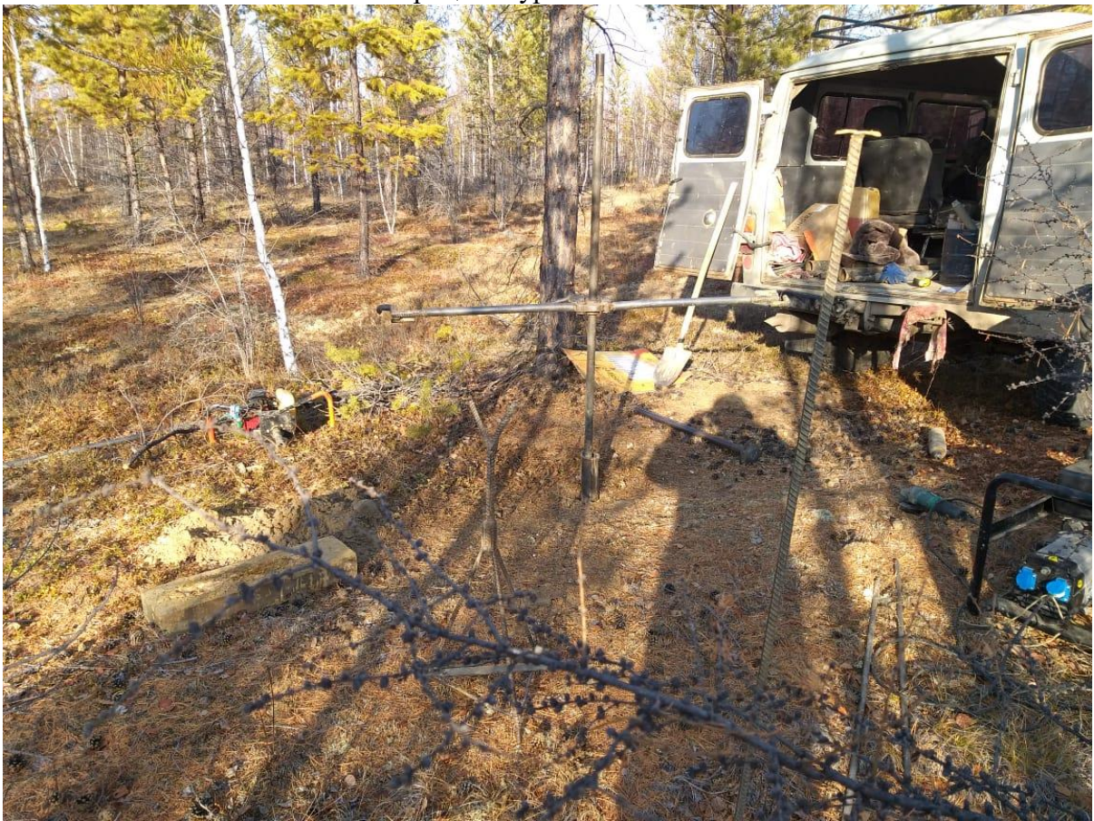
Фото 8. Процесс бурения скважины №15
