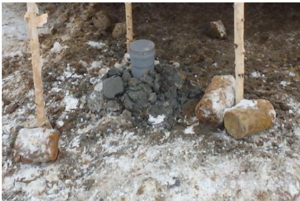
Фото 2. «Выстойка» термометрической скважины.
