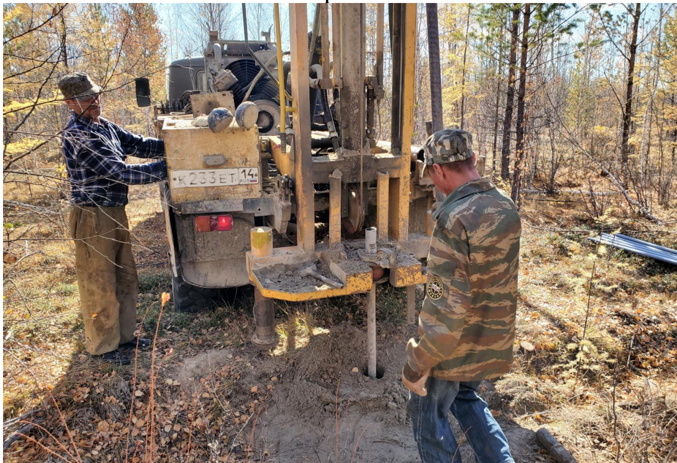
Фото 1. Процесс бурения скважины №2
