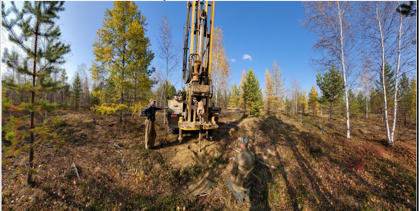
Фото 4. Процесс бурения скважины №7
