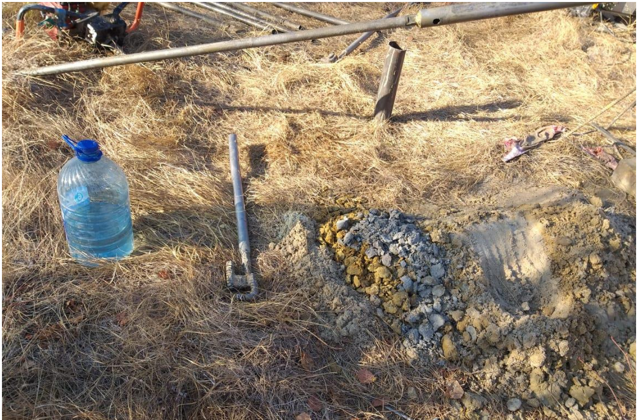
Фото 9. Процесс бурения скважины №22
