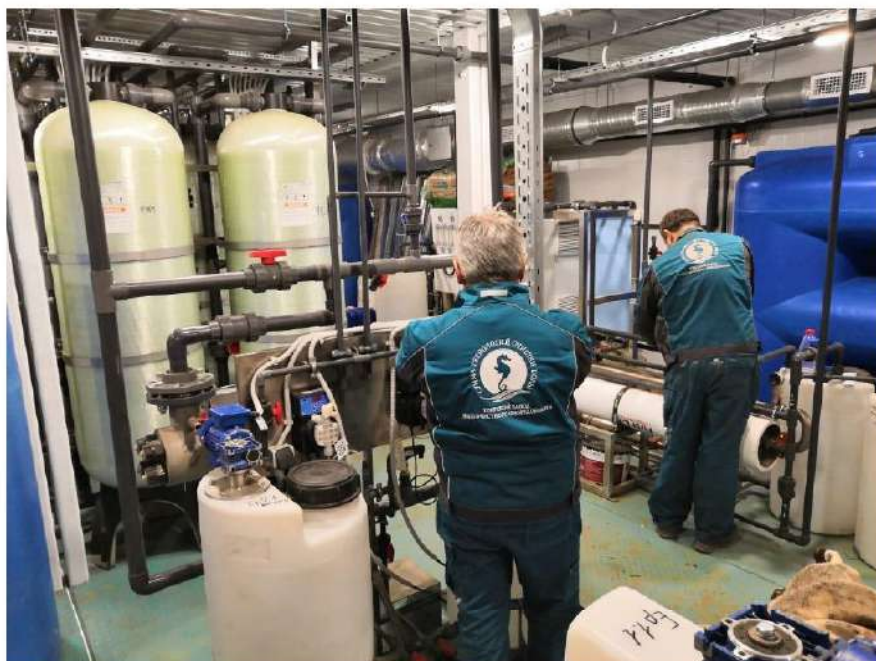
Рис.7 Пусконаладочные работы на объекте ТКО «Солопово»
